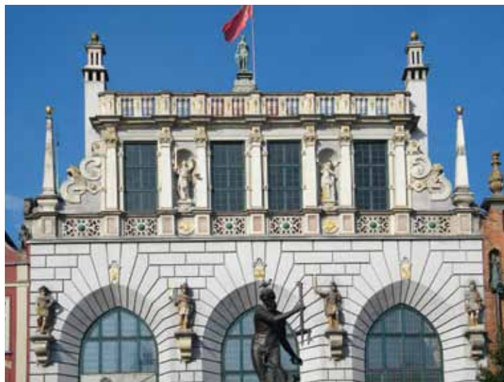
162. Abraham van den Blocke, fasada południowa Dworu Artusa, 1616–1617, Gdańsk
