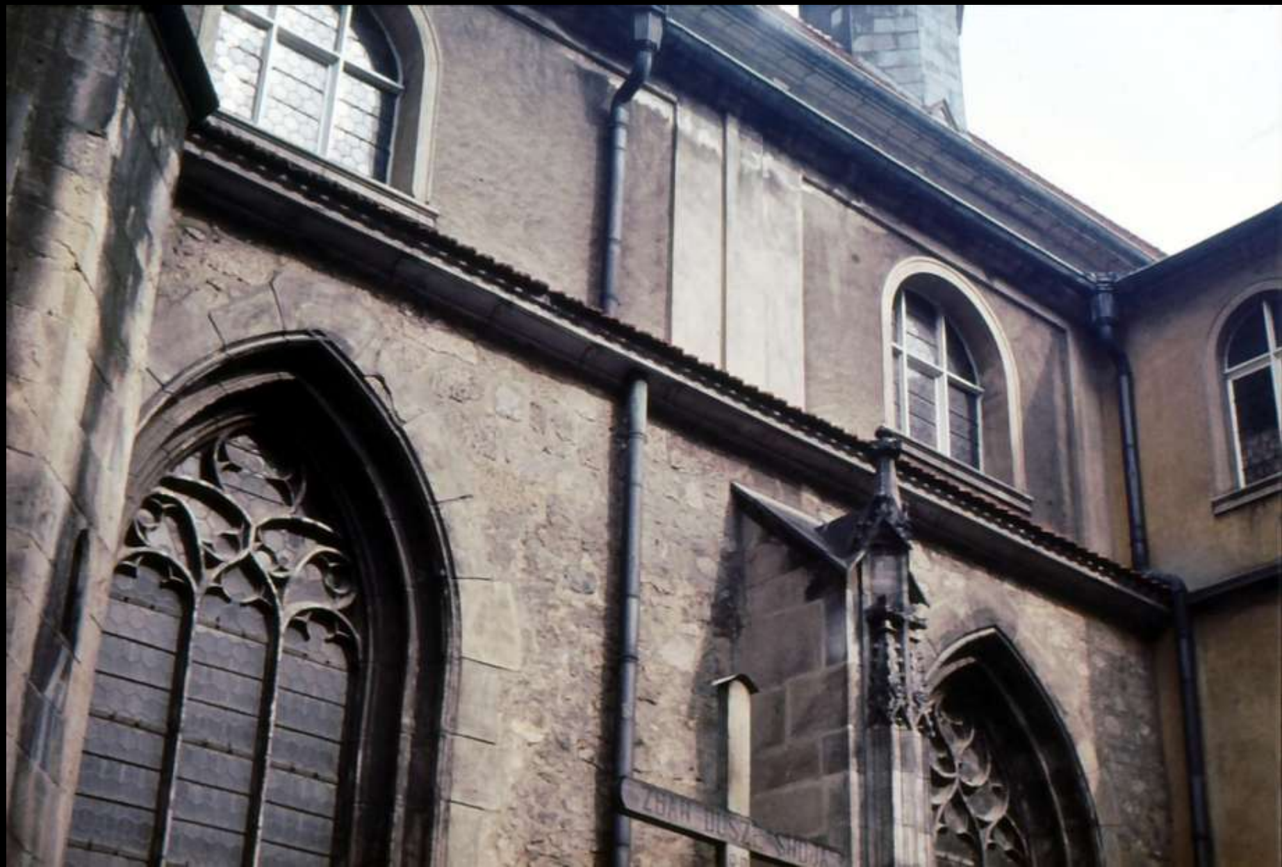
Okno z masferkiem; przypora ze sterczyną (pinaklem)
