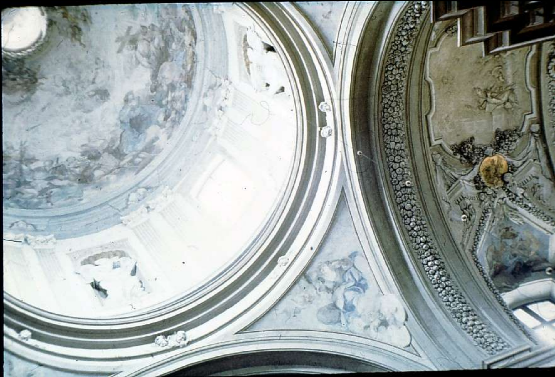
Kopuła na żagielkach na bębnie (widoczna latarnia) i sklepienie kolebkowe z lunetami - kościół jezuicki w Krakowie
