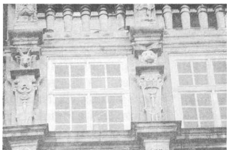
5. Fragment IV kondygnacji.
