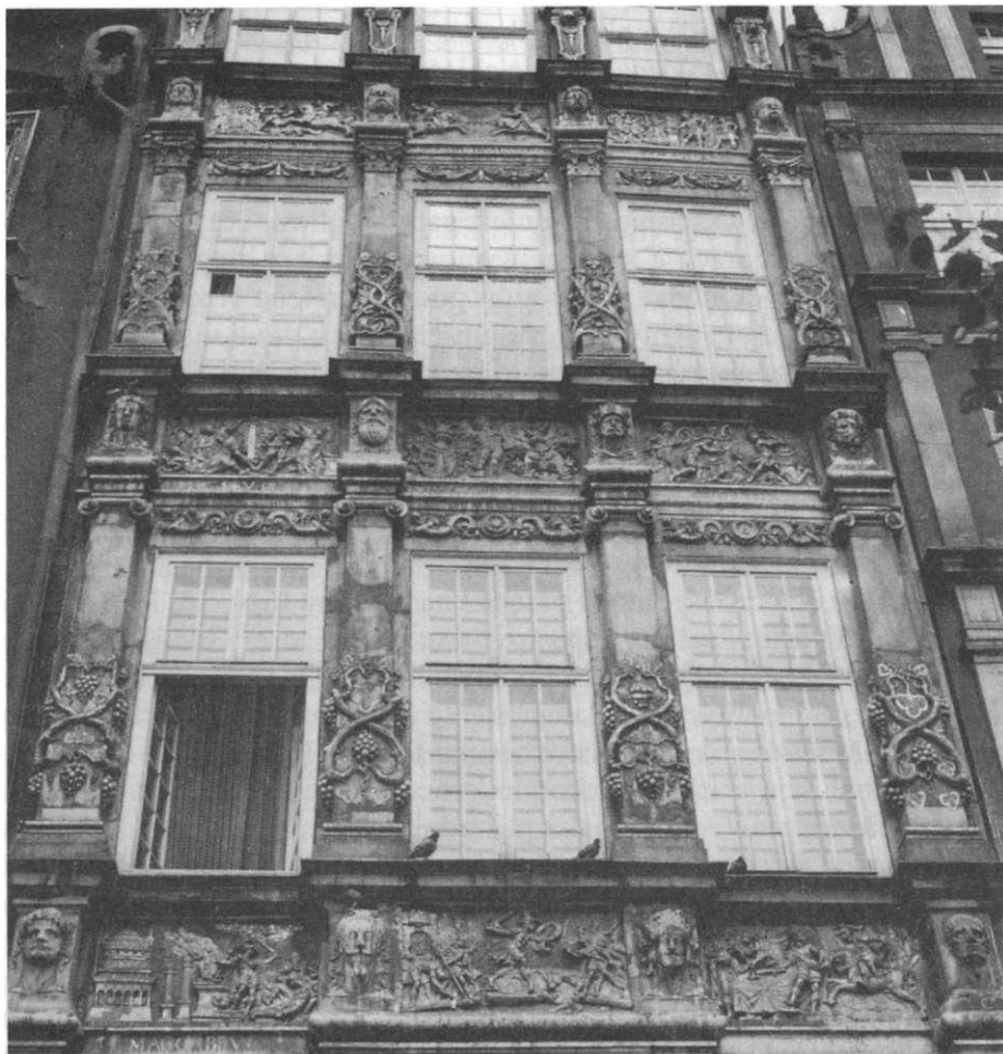
2. Widok drugiej i trzeciej kondygnacji z 1971 r.
