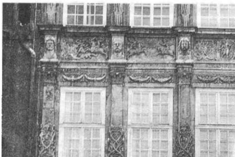
12. Relief IV kondygnacji.
