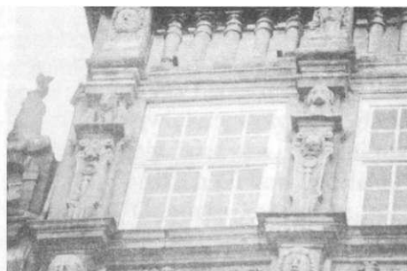
6. Fragment IV kondygnacji.
