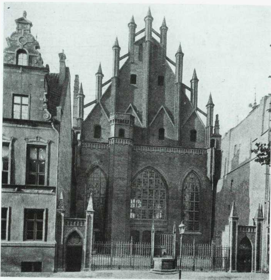
• Gotycka elewacja północna Dworu Artusa.
