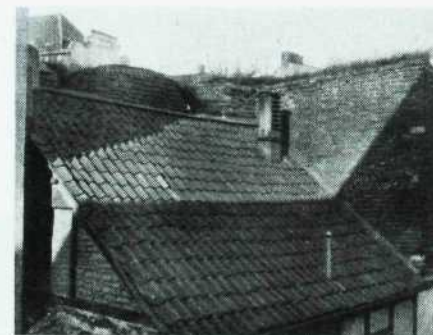
• Fragmenty murów obronnych widoczne spod późniejszych nawarstwień.
