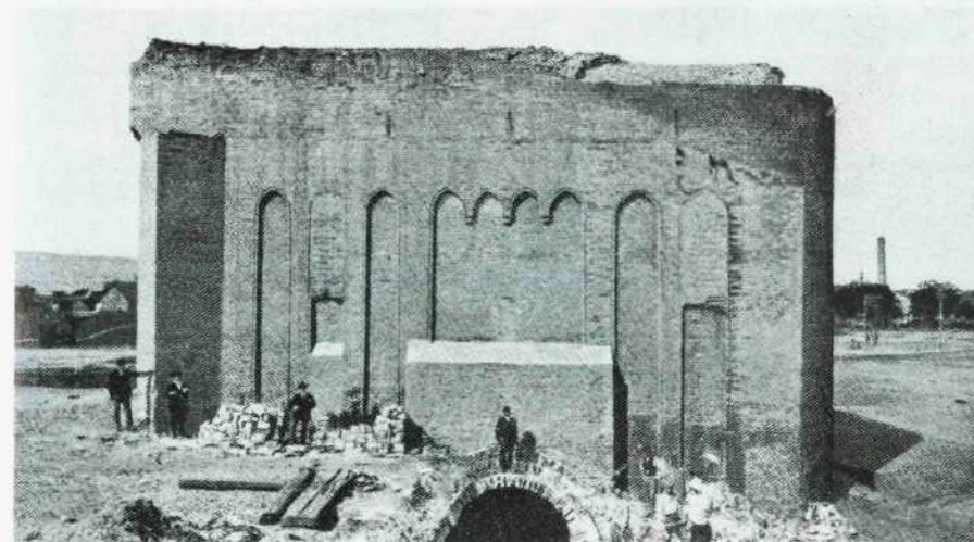
• Brama Karowa podczas rozbiórki
