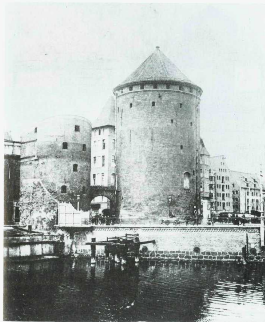
□ Stągwie Mleczne od strony Nowej Motławy.
