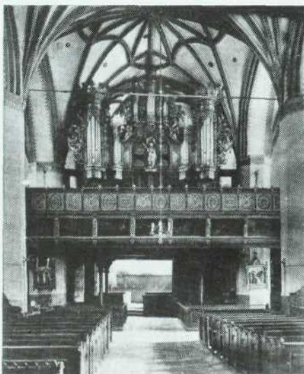
<1 Wnętrze kościoła ku wschodowi.
