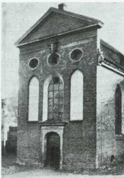
A Siedemnastowieczne skrzydło północne. . .
