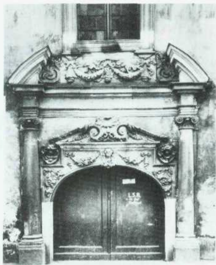
A Portal Kaplicy Królewskiej. . .
