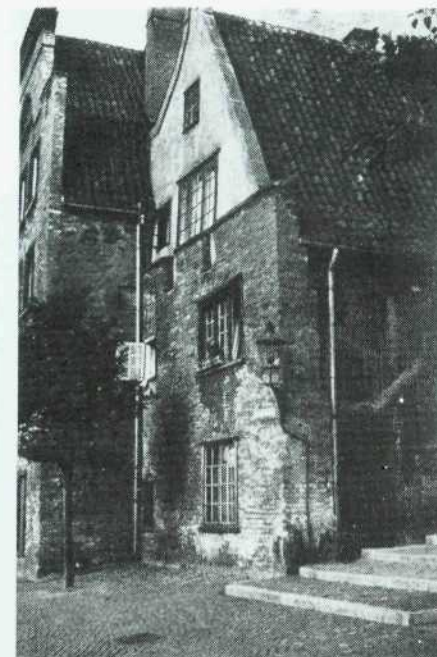
• Fragment muru zamkowego zachowany jako ściana późniejszego budynku.
