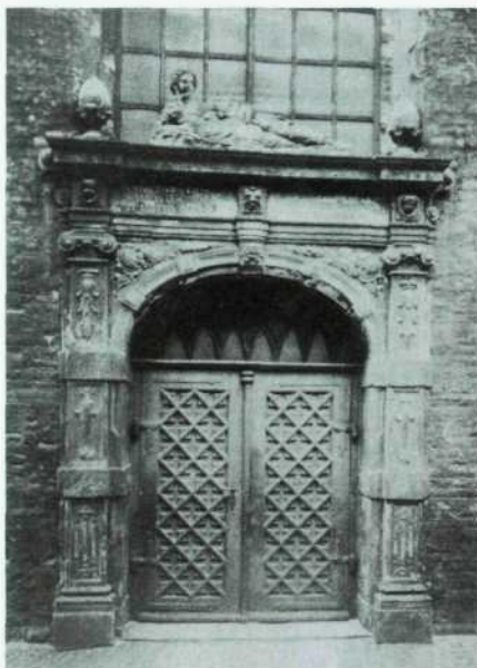
A Portal kościoła św. Bartłomieja.
