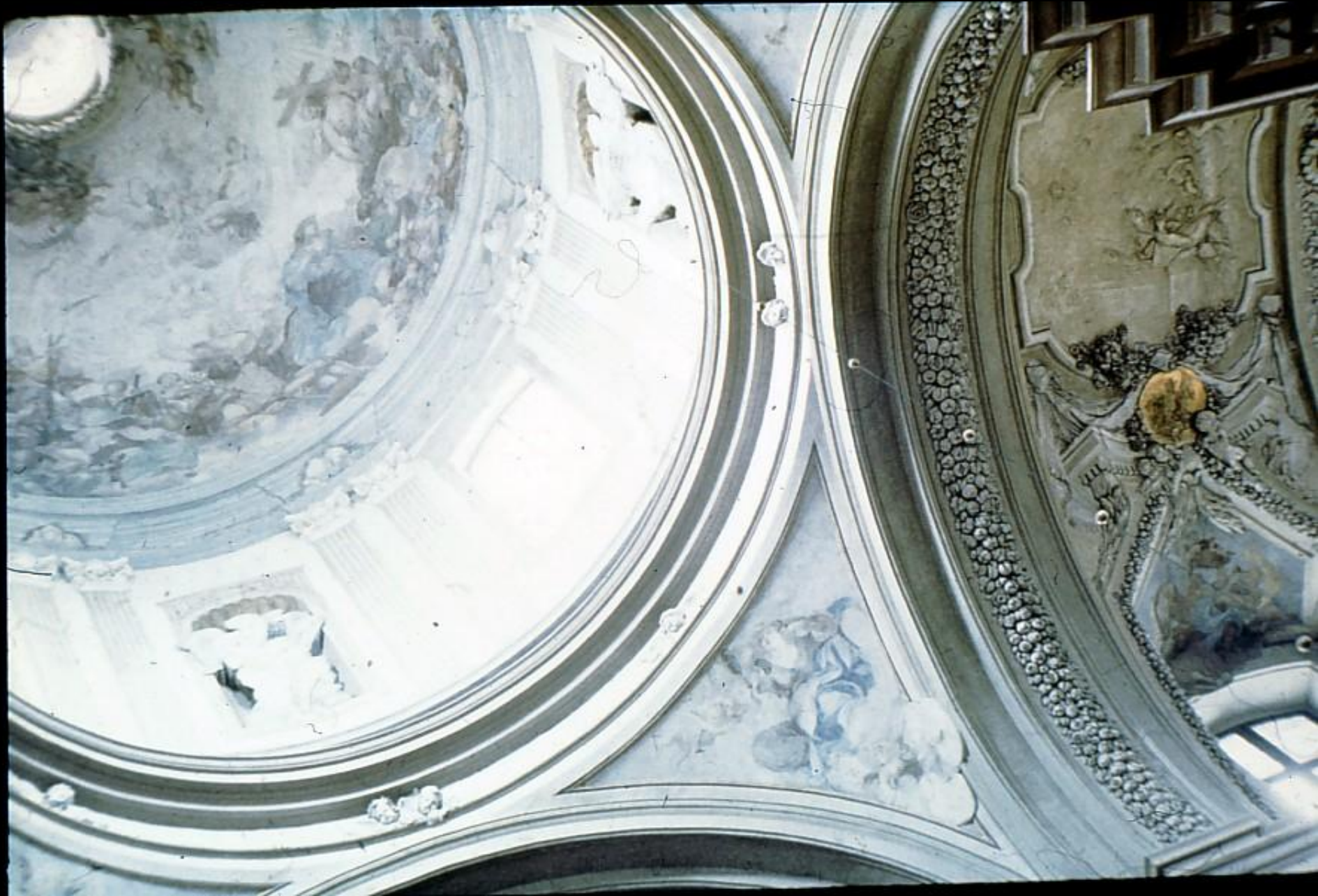
Kopuła na żagielkach na bębnie (widoczna latarnia) i sklepienie kolebkowe z lunetami - kościół jezuicki w Krakowie
